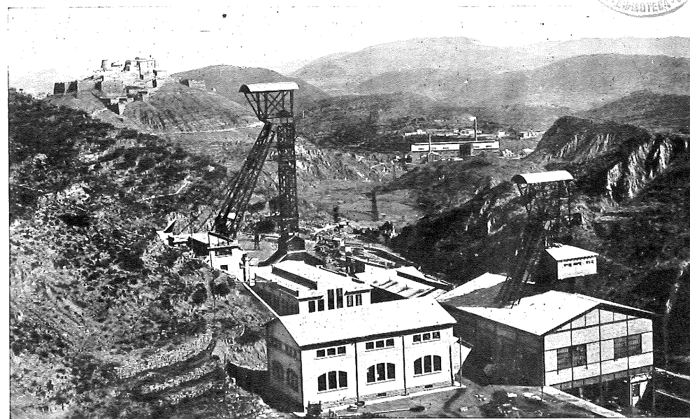
Fot. 2.—Vista general de instalaciones.
